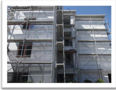
Resim.2.6.1.a. 17.lojman Binası için Yapılan Isı Yalıtımı Uygulaması
