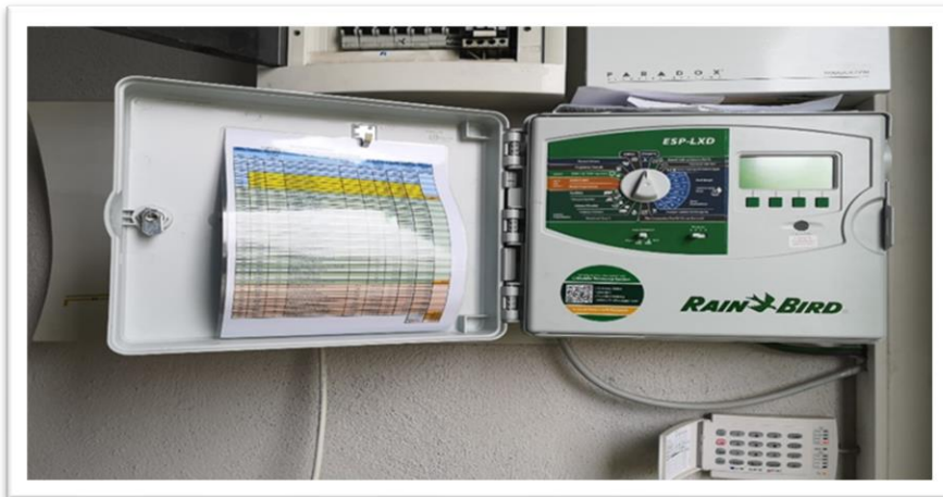
Resim.2.2.j. Sulama Otomasyon Sistemi
