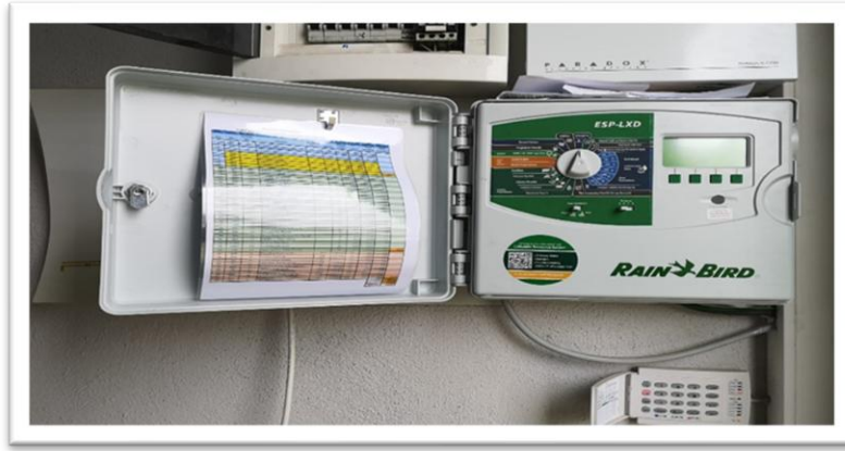
Resim.2.2.j. Sulama Otomasyon Sistemi
