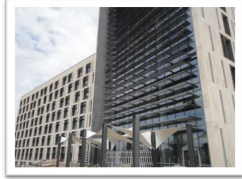
Resim.2.3.b. Pasif Gölgeleme Uygulaması
