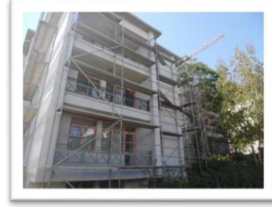
Resim.2.1.2.a. 17.lojman Binası için Yapılan Isı Yalıtımı Uygulaması
