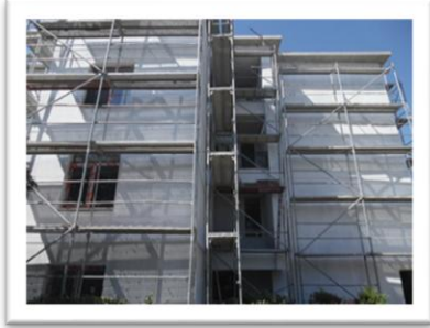
Resim.2.1.2.a. 17.lojman Binası için Yapılan Isı Yalıtımı Uygulaması
