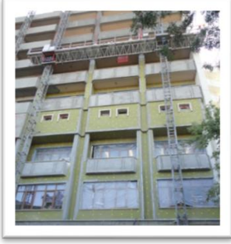
Resim.2.3.a. Isı Yalıtımlı Dış Cephe Kaplama Uygulaması
