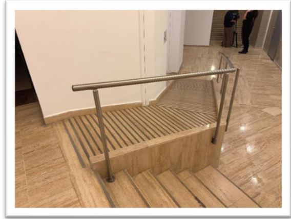
Resim.8.1.4.b. FF Blok Güzel, Sanatlar, Tasarım ve Mimarlık Fakültesi'nde Yer Alan Rampaya Korkuluk Yapılması
