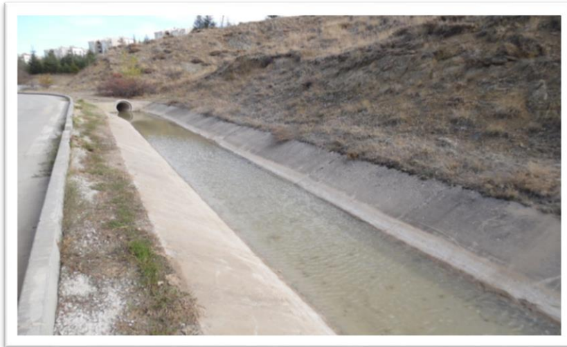
Resim.4.2. Su Geri Dönüşüm Programı Kapsamında Yağmur Kanalları
