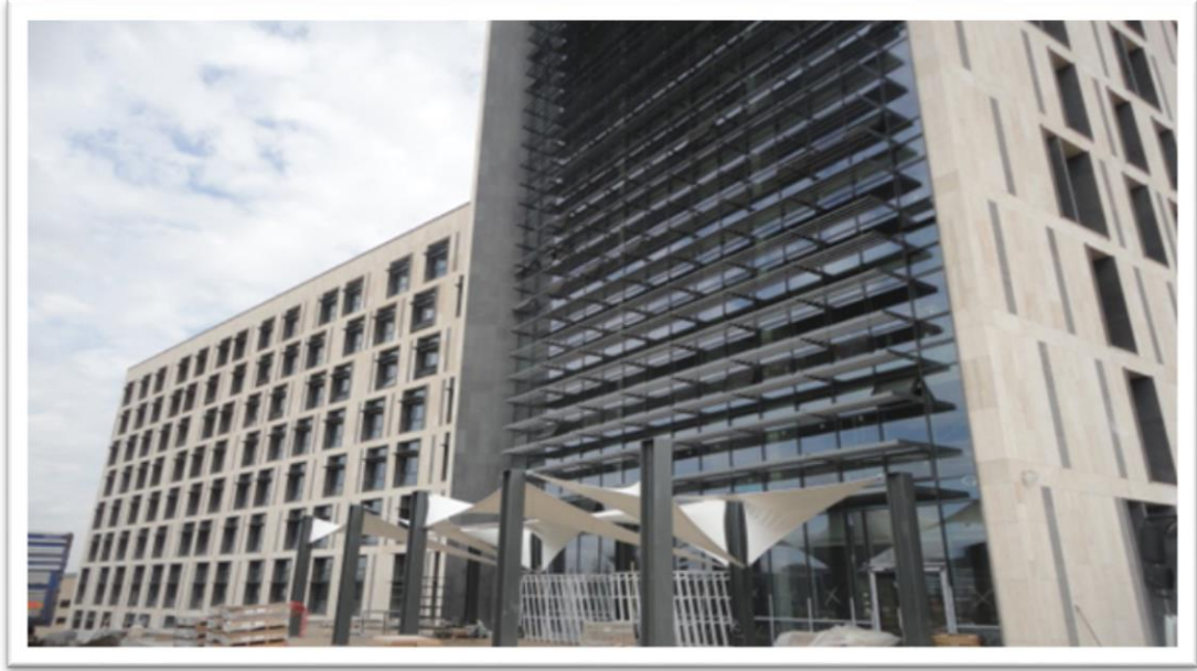
Resim.2.6.1.b. 81-82 Yurt Binası Isı Yalıtımı ve Doğrama Uygulamaları
