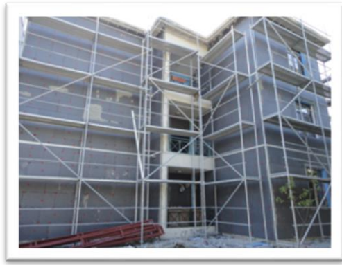
Resim.2.6.1.f. 5. Lojman Binası Isı Yalıtımı Uygulaması
