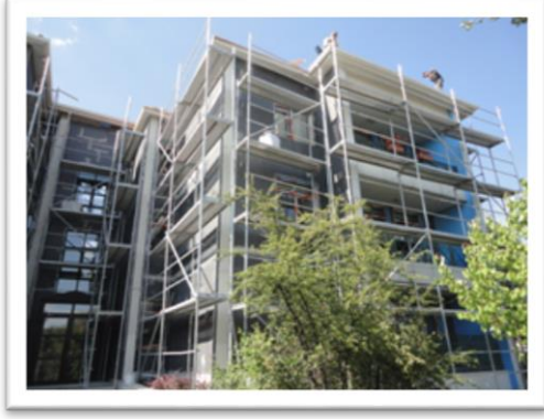
Resim.2.6.1.g. 21. Lojman Binası Isı Yalıtımı Uygulaması
