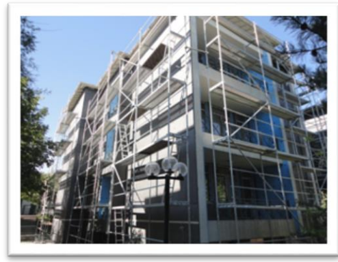
Resim.2.6.1.f. 5. Lojman Binası Isı Yalıtımı Uygulaması
