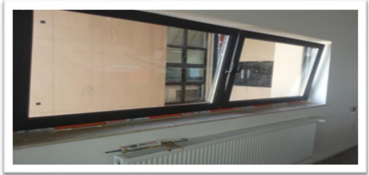
Resim.2.6.1.c. Güzel Sanatlar, Tasarım ve Mimarlık Fakültesi Binası Isı Yalıtımı ve Doğrama Değişimi Uygulaması
