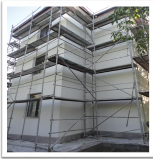
Resim.2.6.1.h. 24. Lojman Binası Isı Yalıtımı Uygulaması
