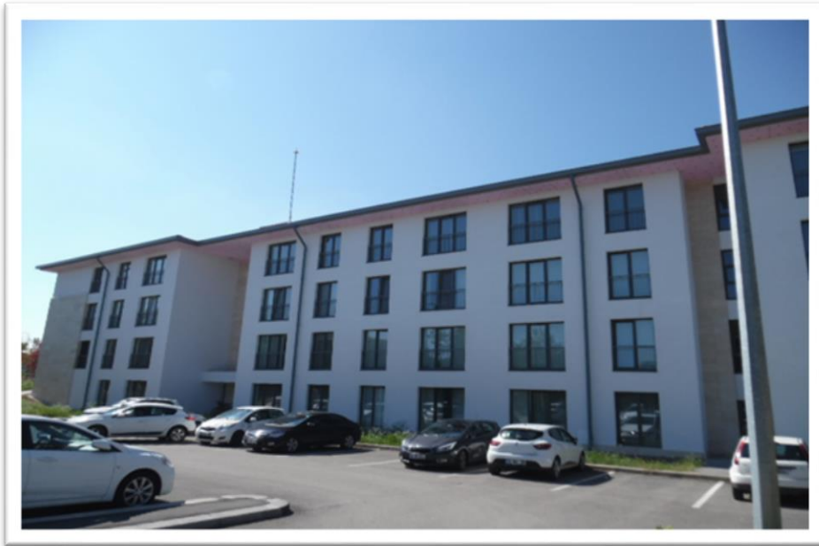
Resim.2.6.1.a. 12-13 Lojman Binası Yapımında Isı Yalıtımı Uygulaması
