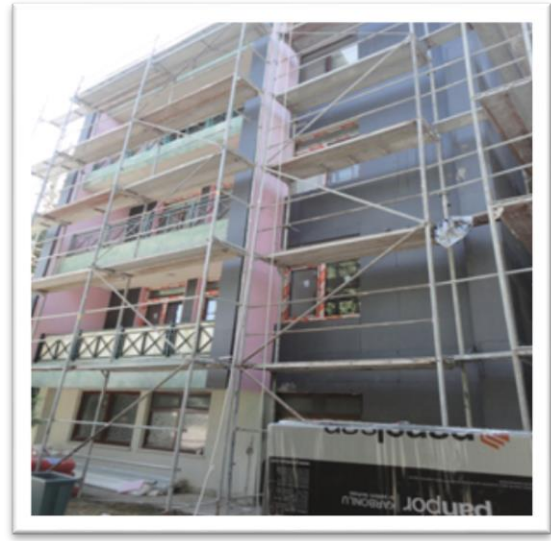
Resim.2.6.1.h. 24. Lojman Binası Isı Yalıtımı Uygulaması
