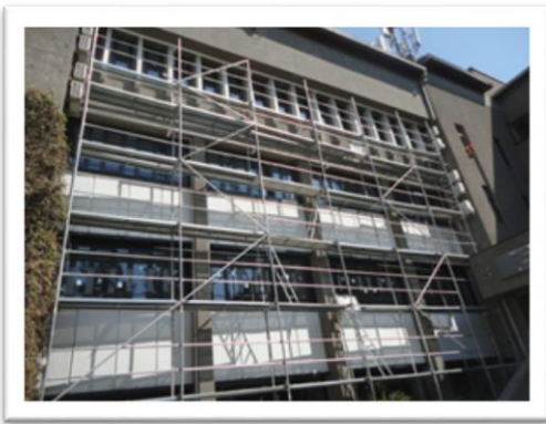
Resim.2.6.1.d. İktisadi, İdari ve Sosyal Bilimler Fakültesi Binası Doğrama Değişimi Uygulaması
